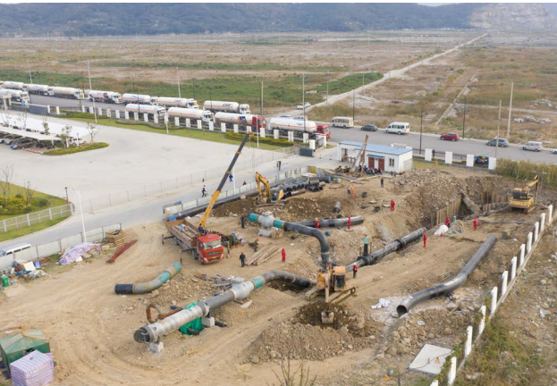
舟山管线施工现场
